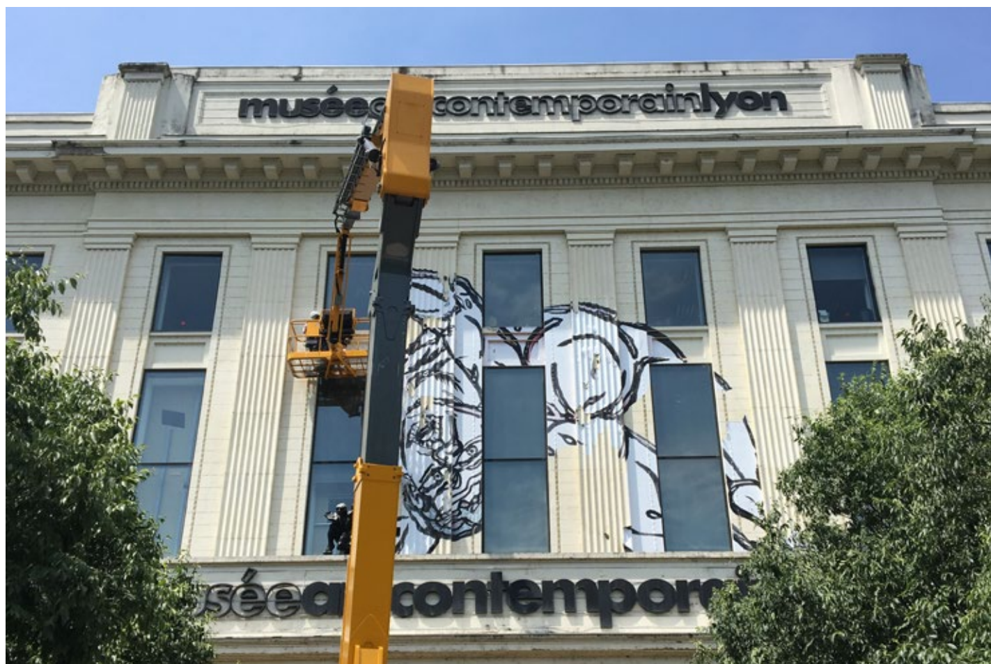
Enlèvement de l'œuvre en façade
