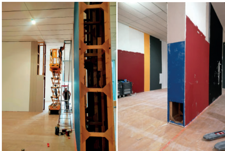
Le réemploi de cloisons visible pendant un montage d'exposition Photos macLYON
