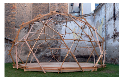
Bear Island Dome Conception 1965, reconstruction 2004, construction à Lyon 2011/2012 Bois de mélèze, 9 m de diamètre. Design de Fuller reconstruit sous la direction de l'architecte Deacon Marvel © Blaise Adillon
