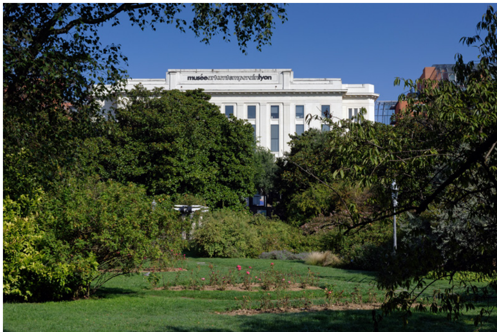
Vue extérieure du maçLYON côté parc, 2019 © Photo: Blaise Adillon
